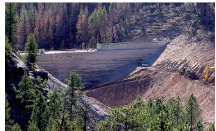
Los Alamos Dam New Mexico (2000)
