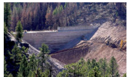
Los Alamos Dam New Mexico (2000)
