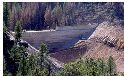
Los Alamos Dam New Mexico (2000)
